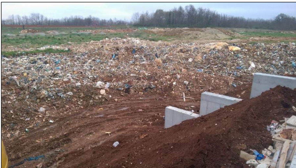
Slika 2.1.-3. Pogled na južnu granicu starog odlagališta "PS Jelenčić V" u gradnji
